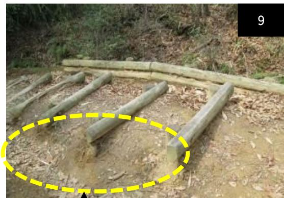
图 8 为防止水土流失所设木制台阶示意图
